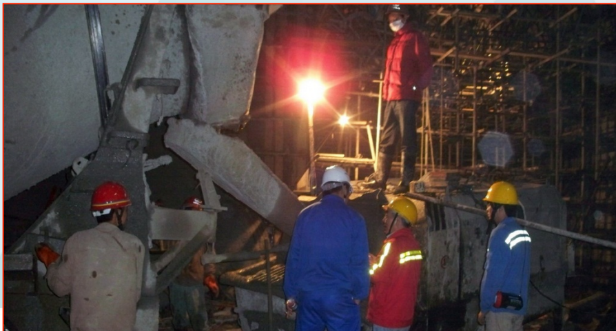
加强混凝土施工过程质量控制
